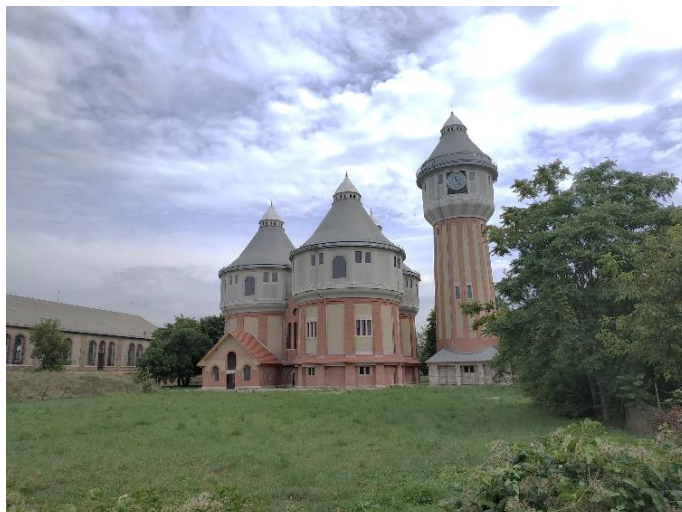
6. fotó Az Óbudai Gázgyár rekonstruált és felújított épületei
