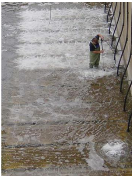
1-3. ábra: Nem működő mechanikai tisztítás és előületítés egyik következménye: lerakódások eltávolításának igénye a levegőztető elemek közötti gyakran mintegy 40-60 cm-nyi rétegben a levegőztető medencéből (fénykép: Patziger M.)
