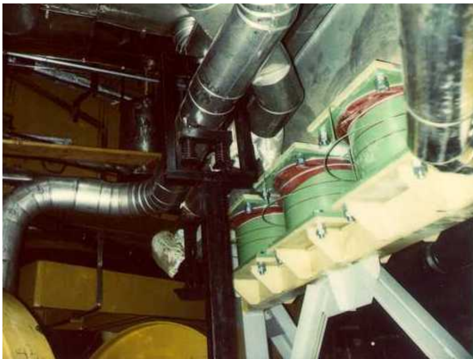
4.7-1. ábra. Viszkózus lengéscsillapítók a gőzfejlesztők alatt
