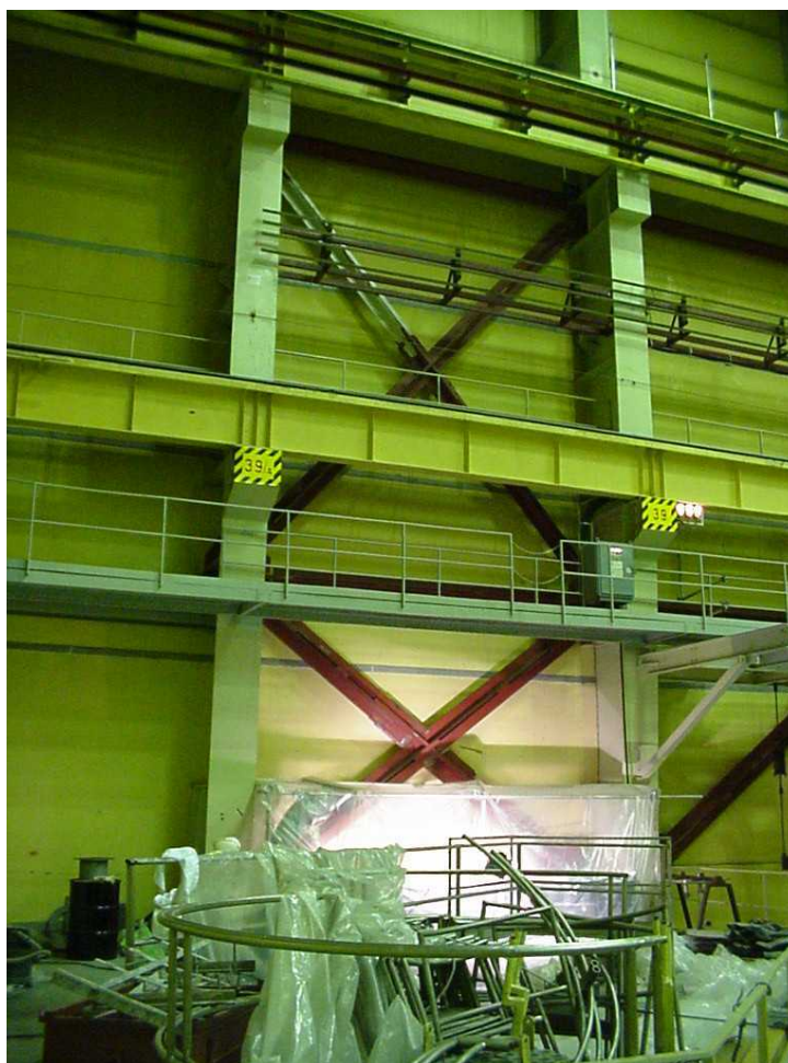
4.7-2. ábra: Hosszirányú megerősítések a reaktorcsarnokban
