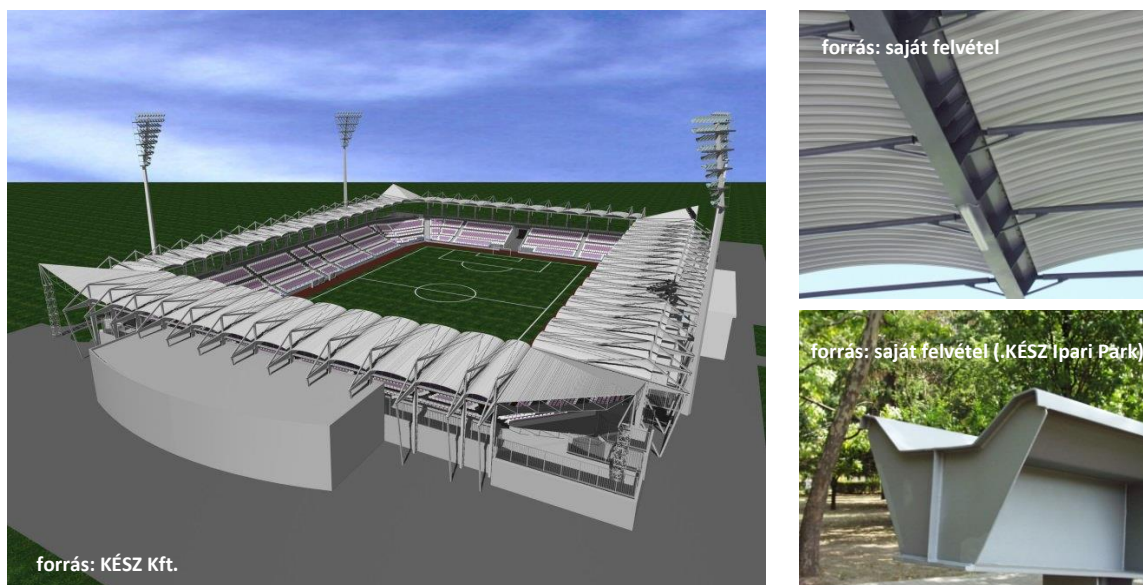
6.1. kép. Az UTE Stadion acélszerkezetének építészeti koncepcionális terve és néhány szerkezeti részlete.
