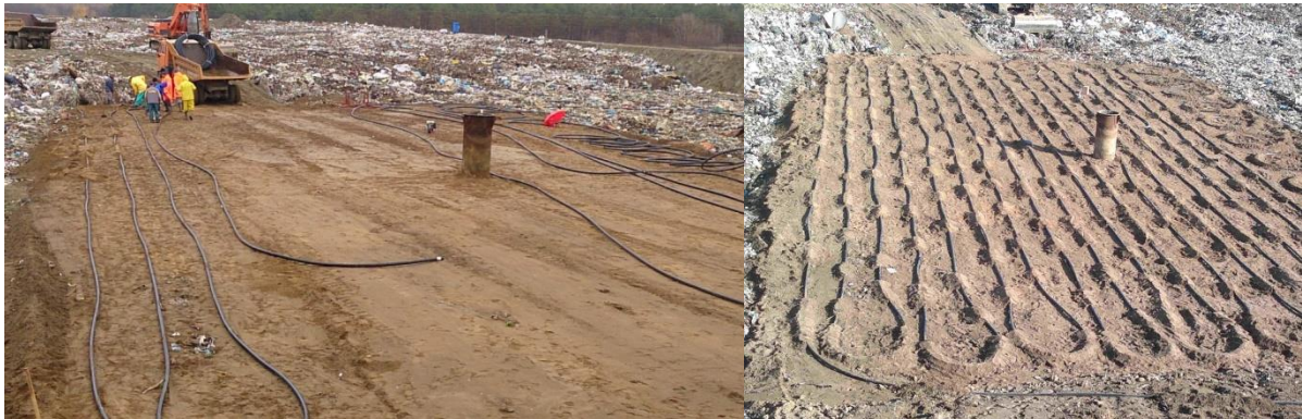
3.1.26. ábra. A “piskóta” és a “hurkos” típusú hőcserélő körök
