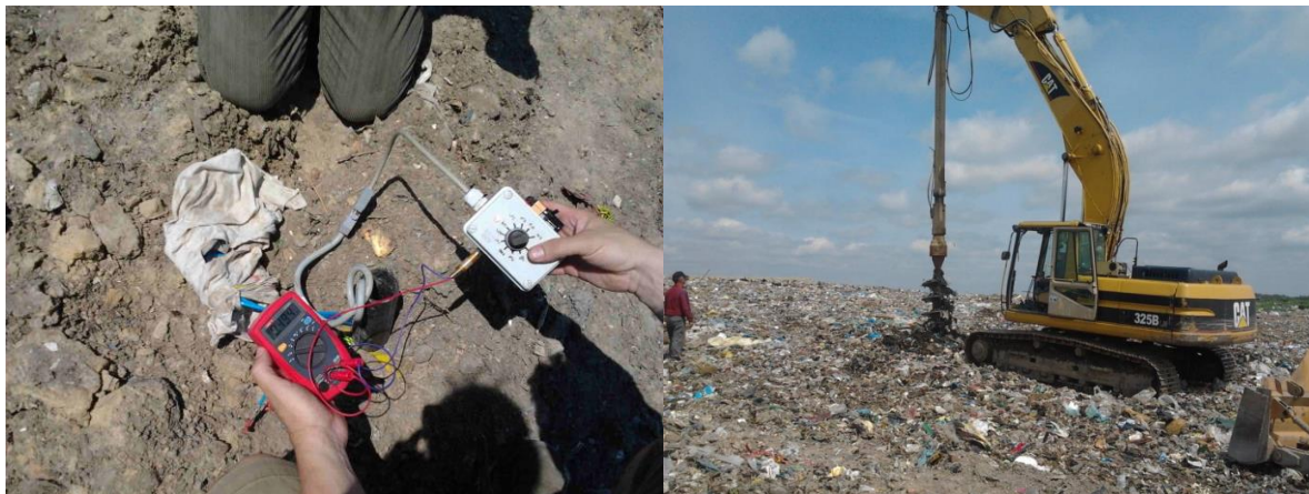
3.1.23. ábra. Hőmérséklet leolvasás egy monitoring kútnál és a furatok kialakítása a depótestben.
