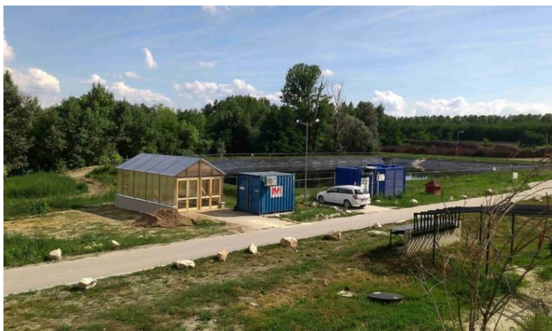
3.1.28. ábra. Az üvegházba és a csurgalékvíz medencébe épített hőcserélők segítségével hasznosítható a kinyert hő
