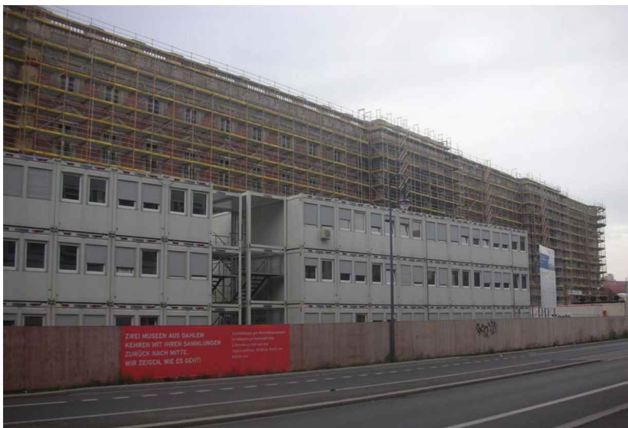
3. kép A Humboldtforum építése (Berlin, 2018)
