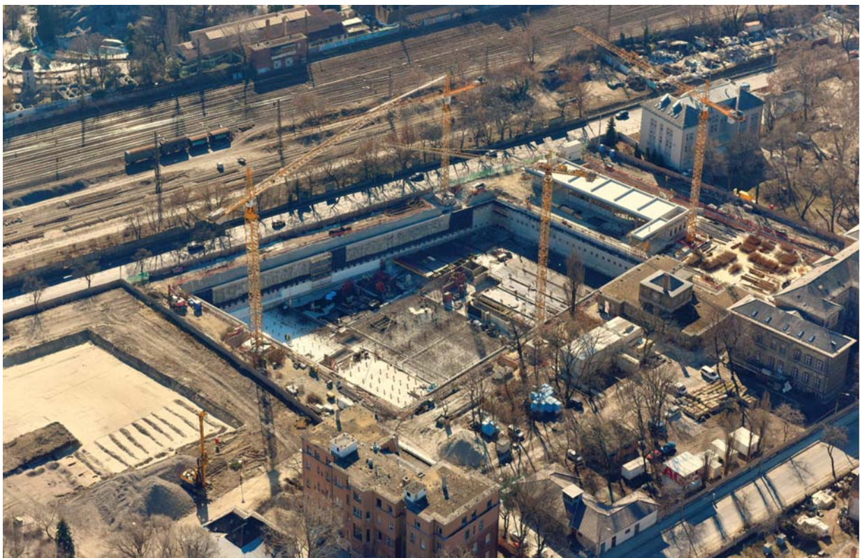
21. kép A raktárbázis kivitelezése (2015)
