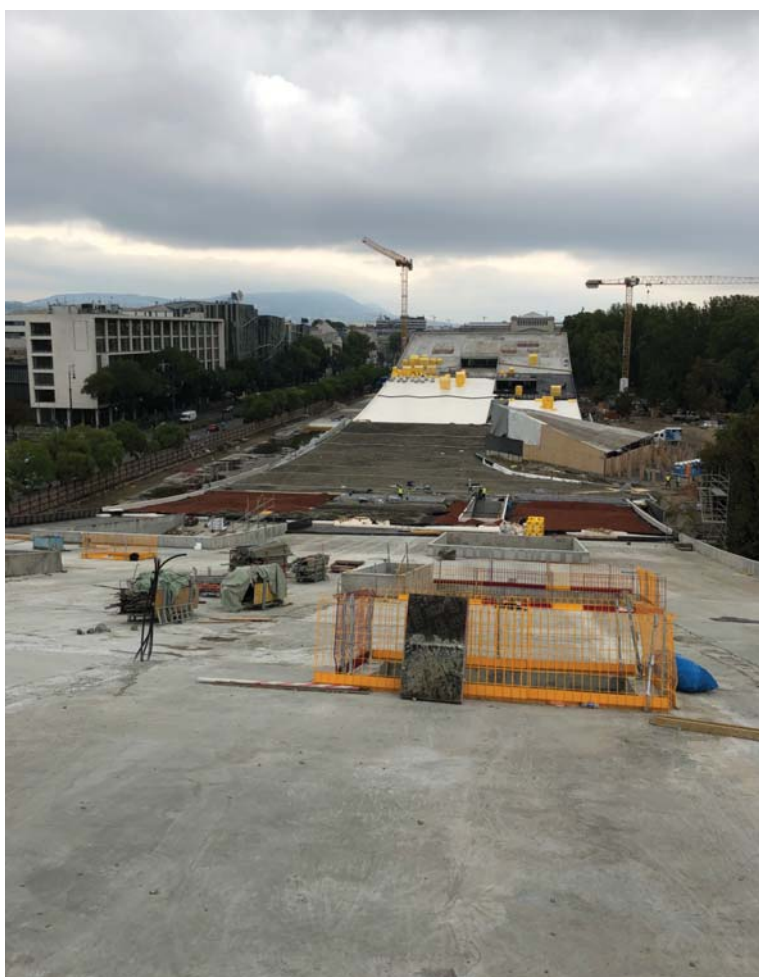
75. A múzeum épülő új főépülete (2020)
