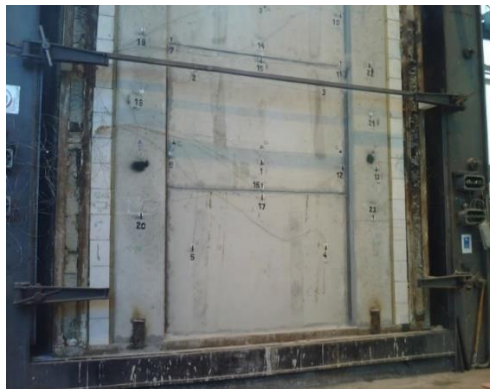
4.3. ábra: A beépített falpanelem (fotó Lublőy, 2018)
