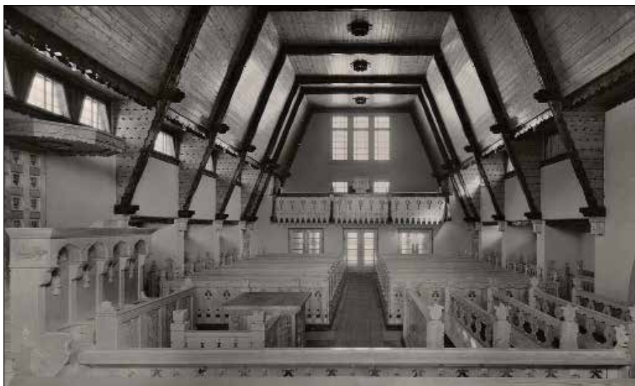
133. kép: A Szeghalmi Bálint műépítész tervezte, 1938-ban átadott miskolci, tetemvári temető református „deszkatemplom” beltere, a Szeghalmi templomtereit jellemző, a nyitott fedélszék érzetét adó, ferde oldalú, gerendavázaz „koporsófedéssel”. A Magyar Filmiroda képeslapja, 1940
