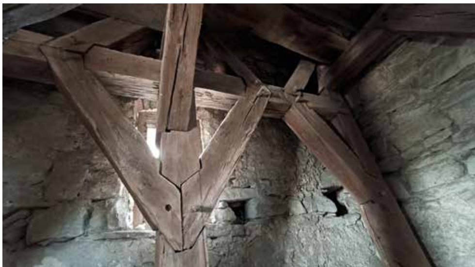
175a és b kép: Kraszna középkori eredetű református templomának 1708-ra elkészült erkélyes, körüljárós harangházának faszerkezete, valamint a harangház tölgyfából ácsolt, csapolt tartószerkezete a kőtorony falain belül. (Foró: FÁ, 2023)
