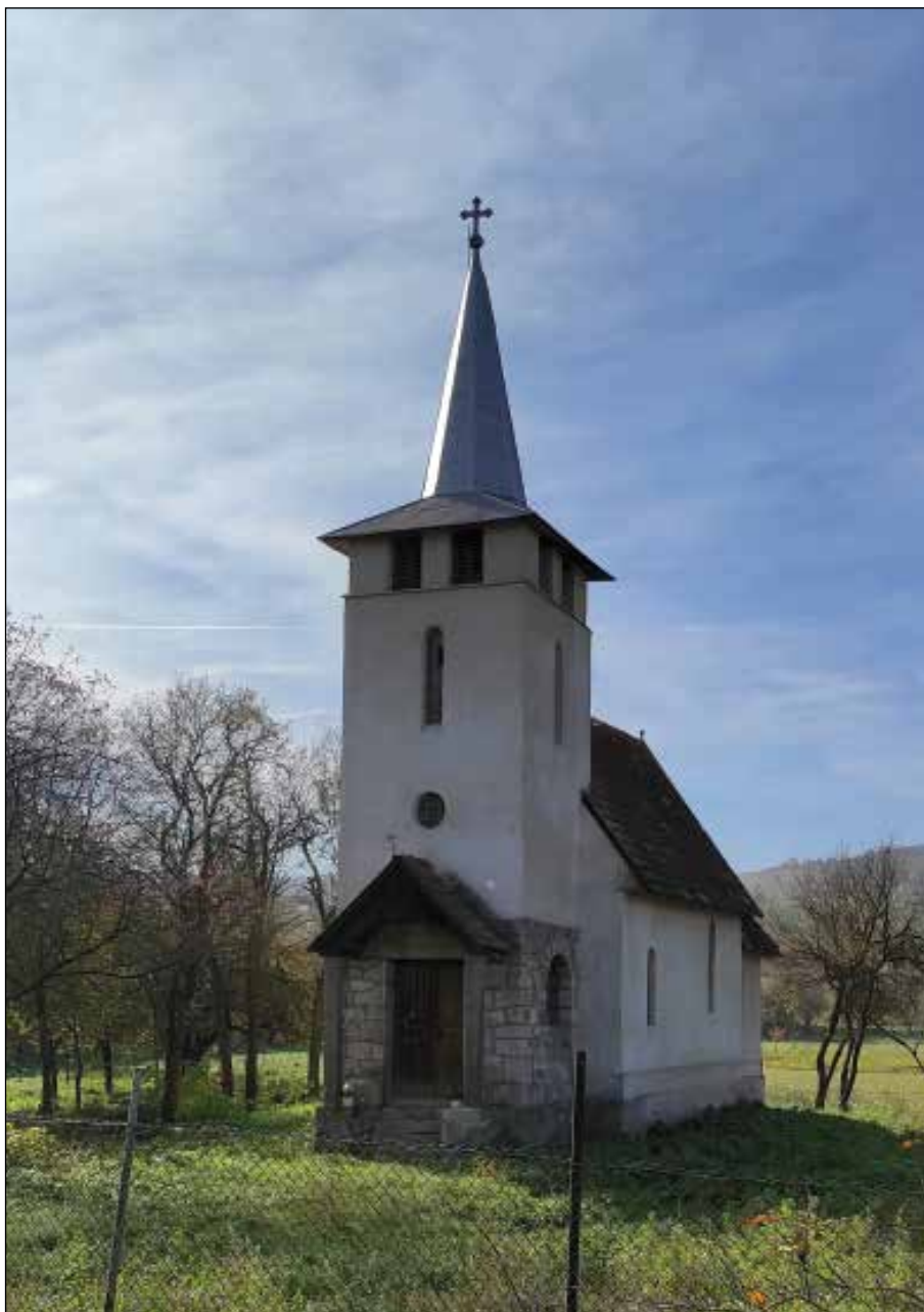
97. kép: Kós Károly 1924-ben készült tervei szerint 1927-ben megépített görögkatolikus (1948 után ortodox) templom Kispetriben. (Belső terébe a Sztánán elbontott, onnan megvásárolt, 1795-ben épült román fatemplom részeit telepítették át, amelyhez hozzáépítették a kőtornyot.) (Fotó: BB, Kispetri, 2021)
