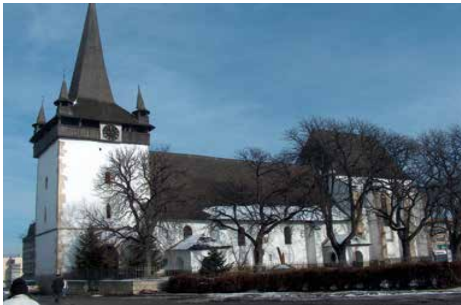
174. kép: A Bánffyhungad főterén álló középkori eredetű református templom déli oldala. A torony kőfala 16. század elején, sisakja az 1770-es években épült. A torony eredetileg az erősített templom 1887-ben lebontott kőfalának bástyája volt. (Fotó: FÁ, 2001)
