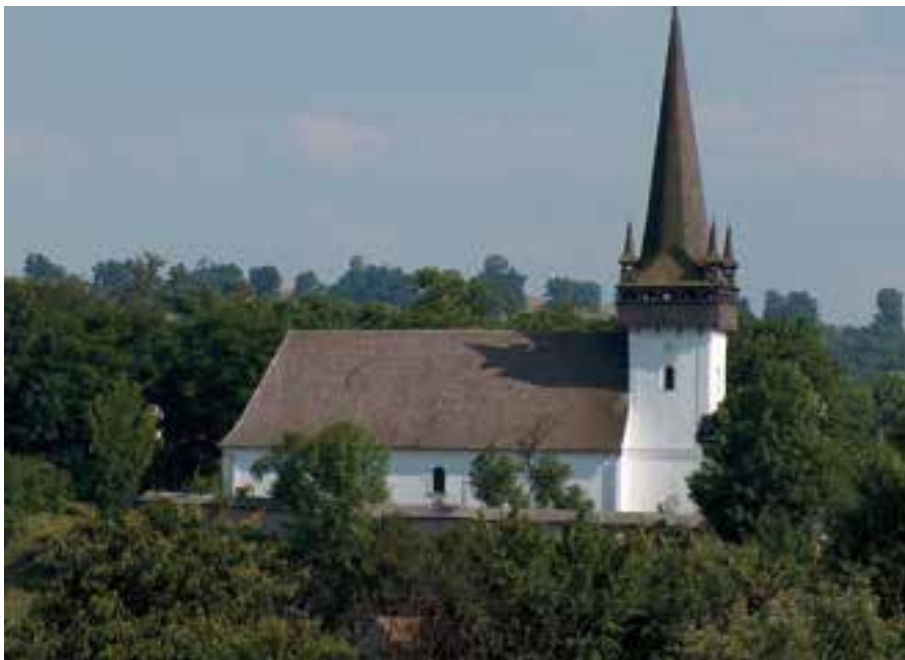
172. kép: Az 1764-ben (egy földrengés után) épült körösfői református templom északi oldala. (Fotó: FÁ, 2004)
