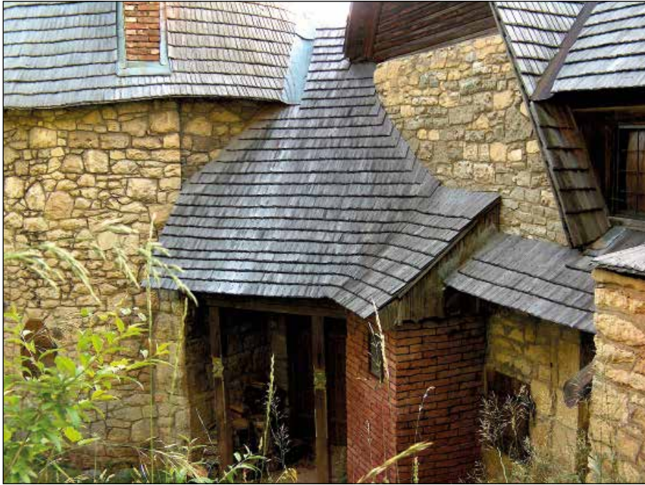
85. kép: Kő, tégl, faragott csillagos faoszlop, zsindelyes tetősíkok – A „Varjúvár” domboldal felőli hátsó oldalának részlete. Kós Károly a sztánai vasútállomás közelében álló házát 1909-ben tervezte, 1910-ben építette meg, majd 1925-ben bővítette. (Fotó: FÁ, 2003)
