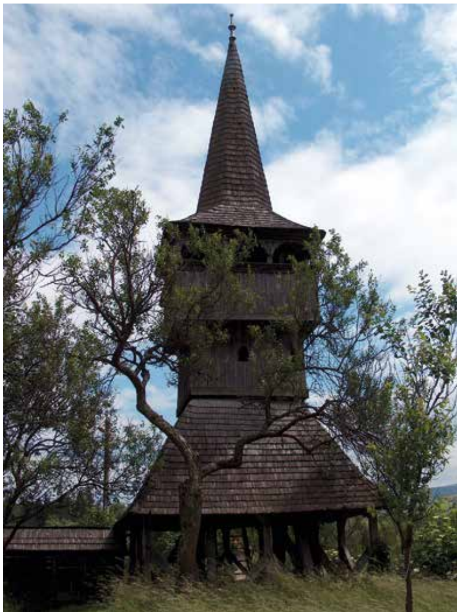
178. kép: A farnasi harangláb. A középkori templom mellett a 18. század elején tölgyfából épült, kőalapzaton álló, szoknyás harangláb, jelentős népi építészeti emlék. Harangjai között van egy 1475-ből származó. (Fotó: FÁ, 2005)
