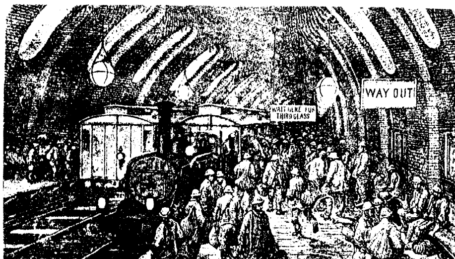
A londoni Metropolitan Railway alagutja. /1864/ A képen jól kivehető a hátrómsines /1435 és 2135 mm nyomtávu/ pálya.
